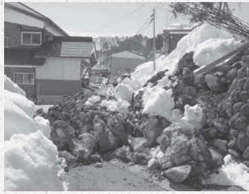
崩れて道路をふさいだ石垣
