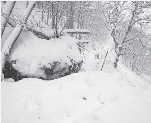
↑結東地内での落石
