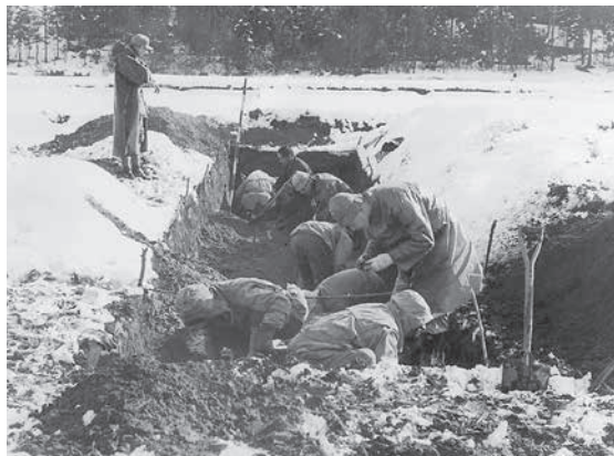
本ノ木遺跡の第1次調査風景
