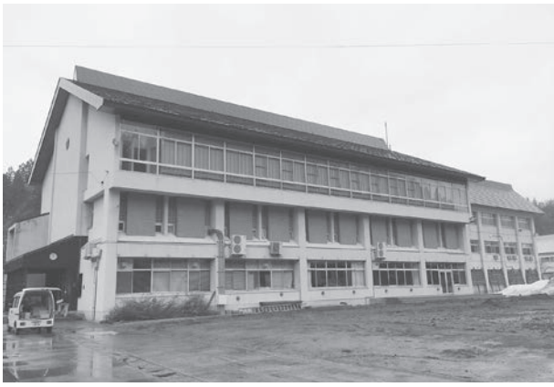
↑校舎の改修を終え、完成が近づく旧上郷中学校
