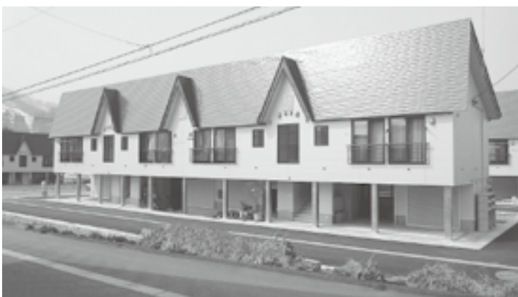
↑ 平成26年3月に完成した町営住宅D棟
