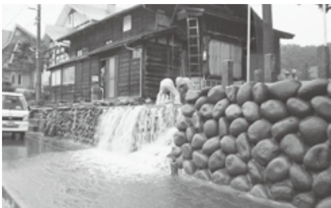
↑土嚢を積み水路からあふれた水を逃がす消防団員(卯ノ木地区)
