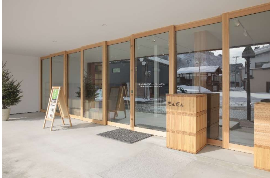
図 津南停留所近隣にあるオープンスペース「だんだん」 町内の学生に、下校時の路線バスの待合場所として活用されている
