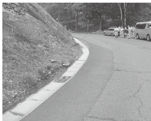
大井平側溝・舗装
