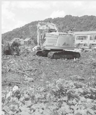
自然を取り戻したい建設予定地
