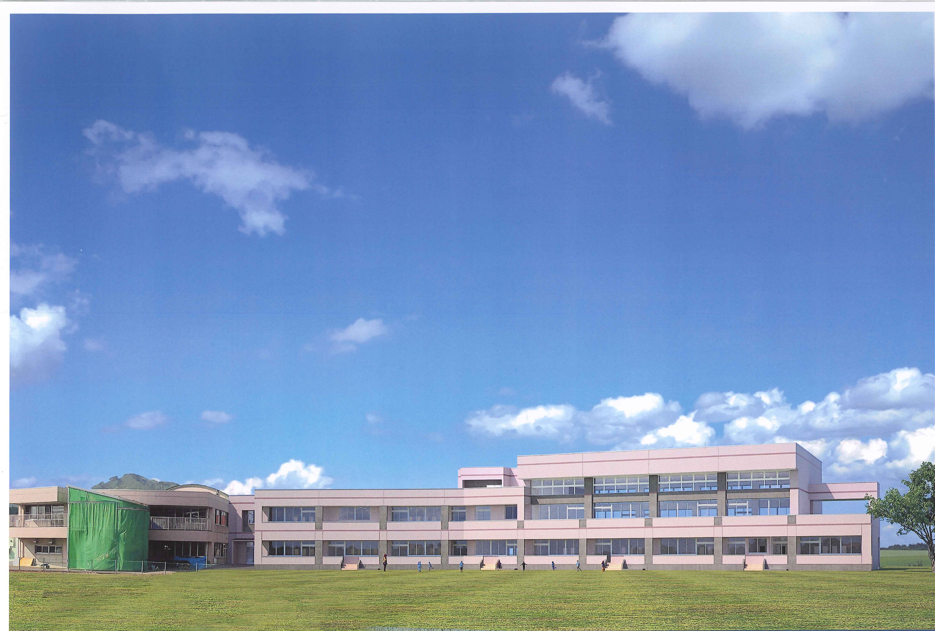
津南町立ひまわり保育園増築工事
