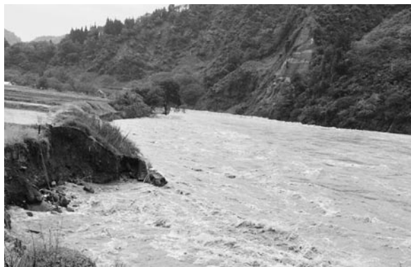
河岸崩壊（割野上島）
