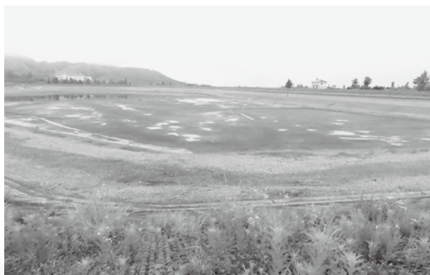
大谷内ダムの湯水状況
