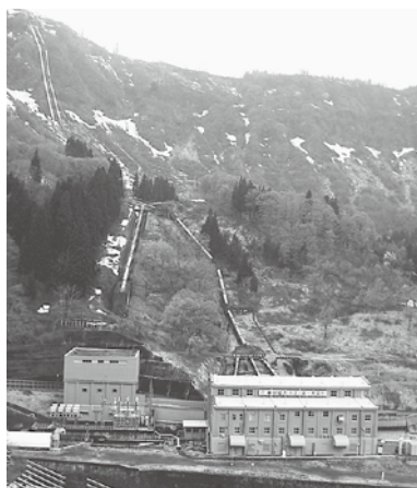
導水路のさらなる安全対策を
