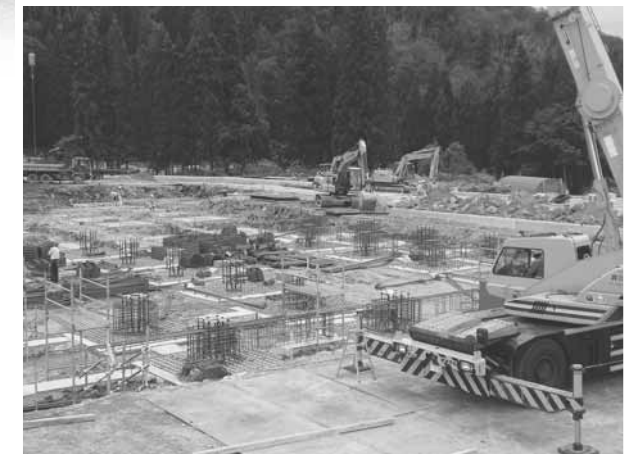
水工場の建設
