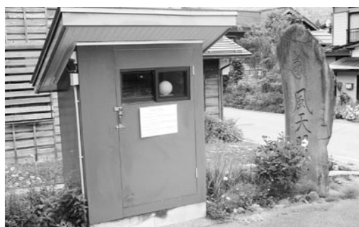
自然エネルギーの活用を (太田新田ミニ水力発電)
