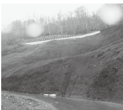
町道新清水屈岨線災害復旧工事
