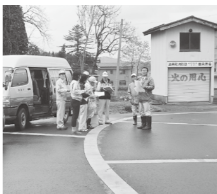
赤沢東線消雪パイプ布設換
