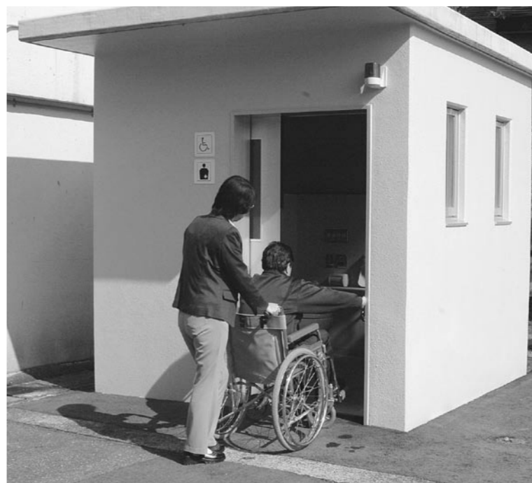
新設された役場前の障がい者用トイレ(完成後、議会で車イスに乗って使用検証)
