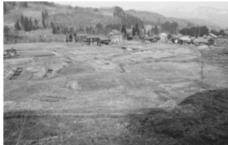
本格的に工事着手する県営事業(加用地内)
