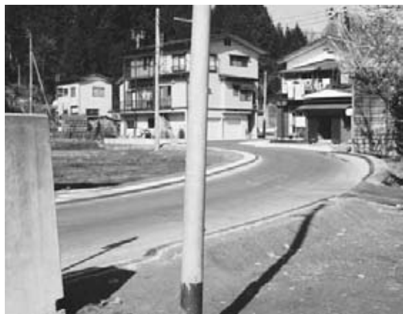
改良工事の完了した集落内道路
