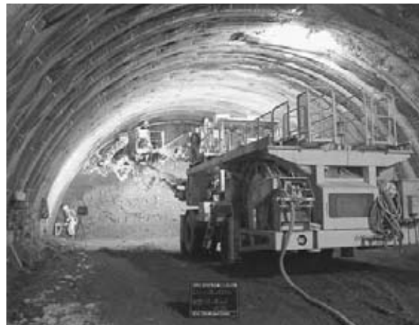
掘削工事の進む大倉トンネル
