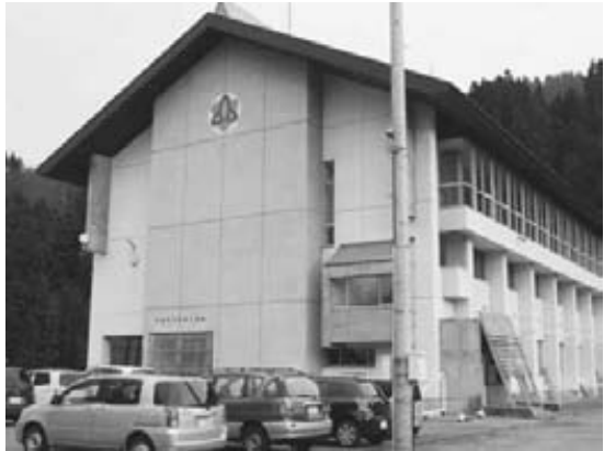
耐震診断が実施される中津小学校
