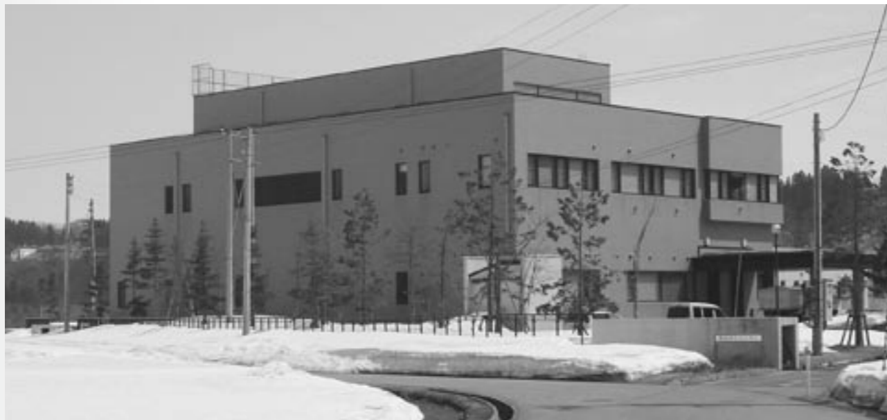
平成19年度において本管工事が完了した下水道事業
