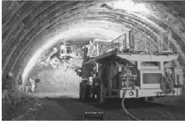
掘削工事の大倉トンネル
