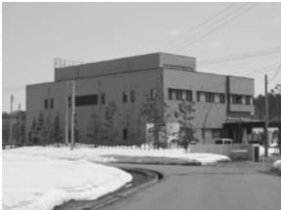
終末処理場 本管工事は完成したが
